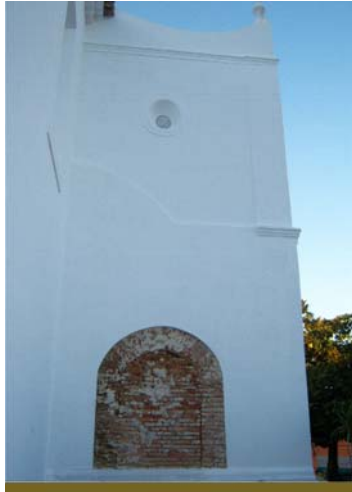
Figura 5: Torre sineira com santuário evidenciado.
